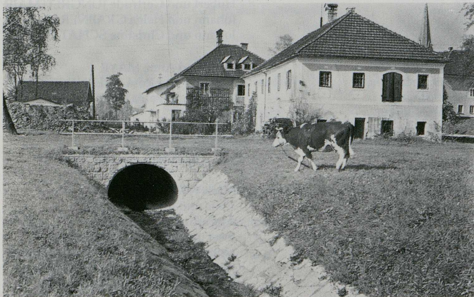
Mündung des Minithalbaches in den verrohrten Abschnitt. Das Schörgenhumerhaus wurde mittlerweile abgetragen
