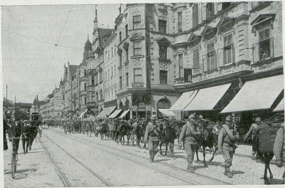
Goldenauszug in Linz (Maschinengewehrabteilung) mit einer prächtigen Ansicht der äußeren Landstraße.
