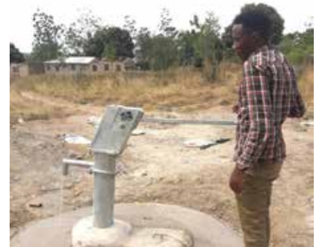
Der vierte Brunnen konnte in Betrieb genommen werden, ein weiterer ist bereits im Bau.
