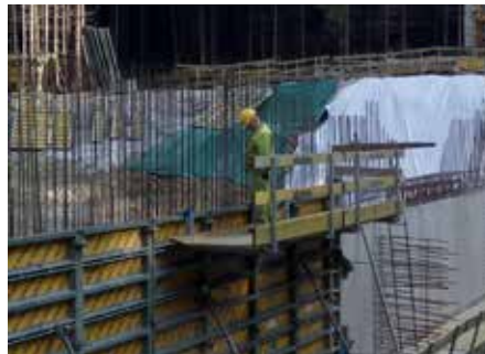
Die Arbeiten an der Hochwasserdosiersperre schreiten zügig voran.
