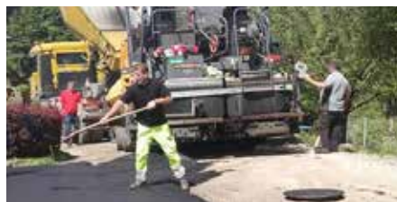
Beschädigte Straßenzüge werden saniert
