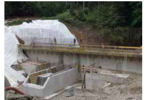
Der oberste Bauabschnitt konnte bereits erreicht werden.
