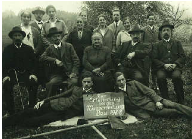
privater Wasserleitungsbau im Jahr 1928
