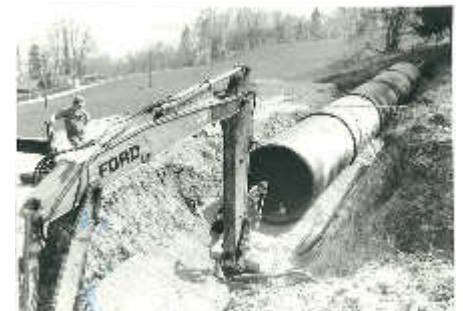
Bau des Röhrenbehälters Rißzaun,
