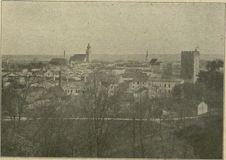
Mühlendorf (Blick von den Anlagen aus)
