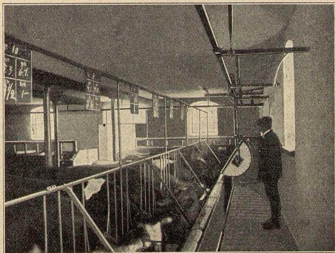
Fressgitter, Hängebahn und Drahtglasfenster. „Arato-Werk“, Breslau.
