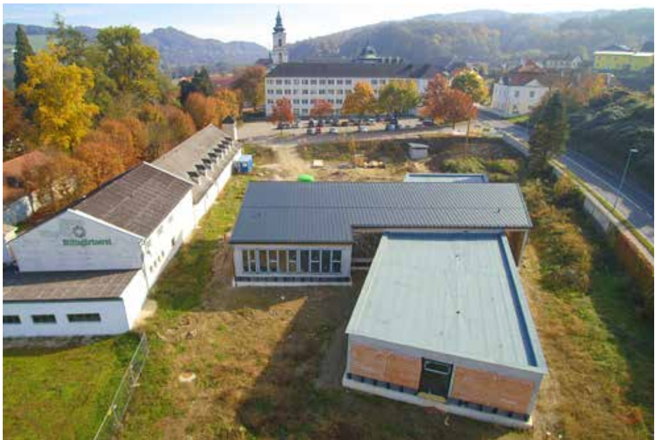
Baufortschritt im November Aufnahmen: Helmut Öttl Photography (foto-oettl)
