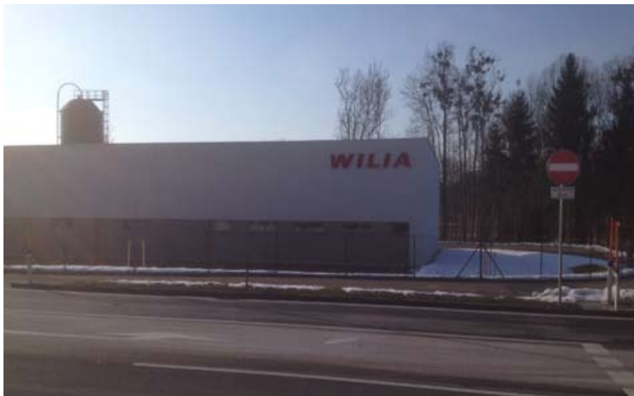
Die neue WILIA-Garage an der Mühlbachkreuzung
