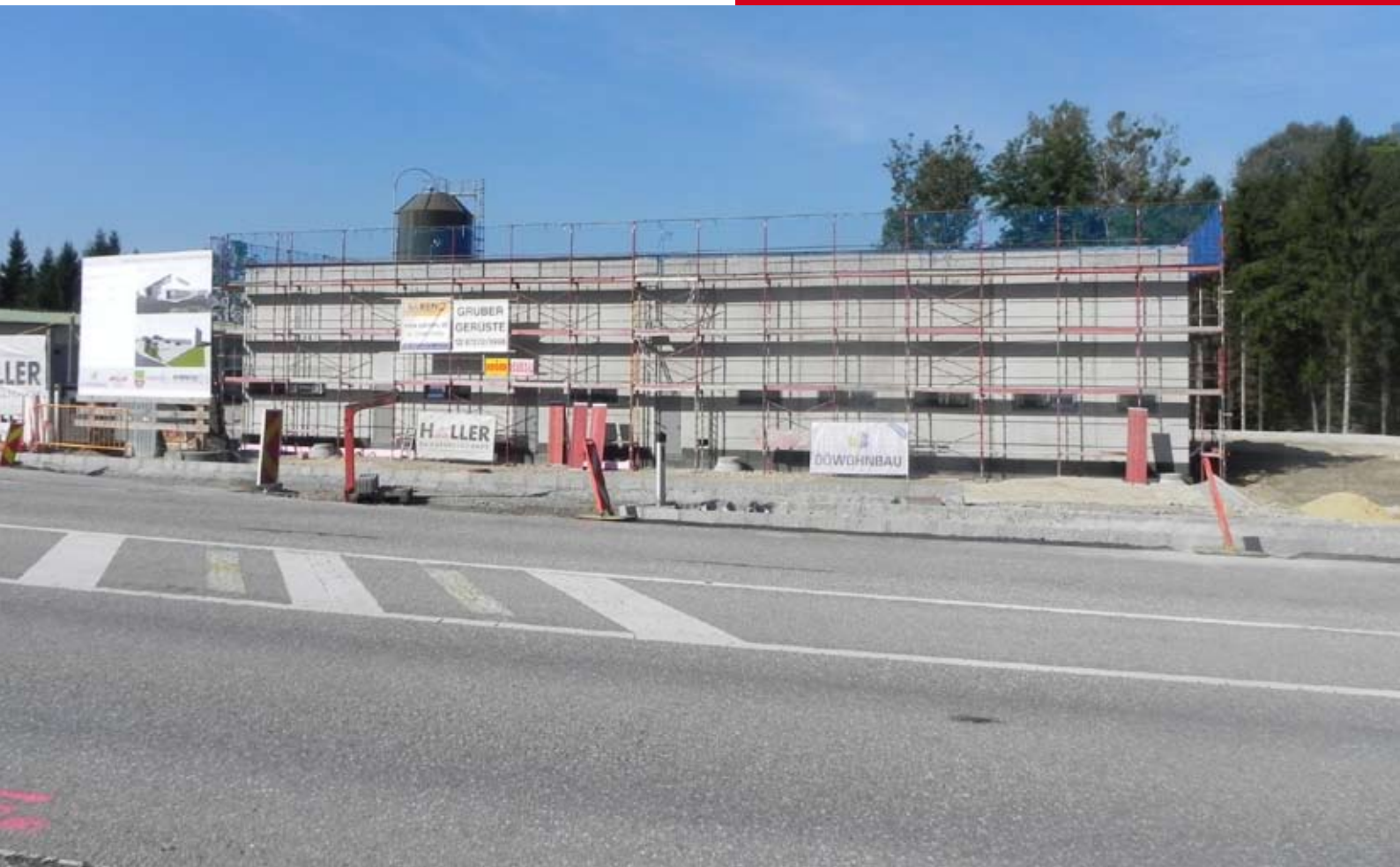
Bau der neuen WILIA-Garage
