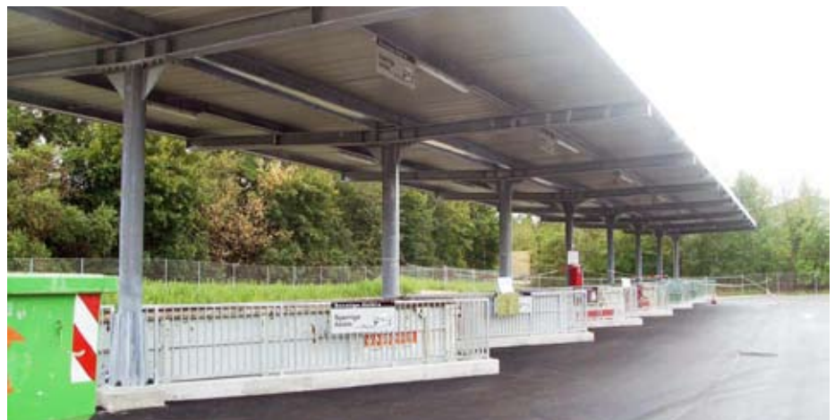
Die Sägezahnrampe eines neueren Altstoffsammelzentrums.
