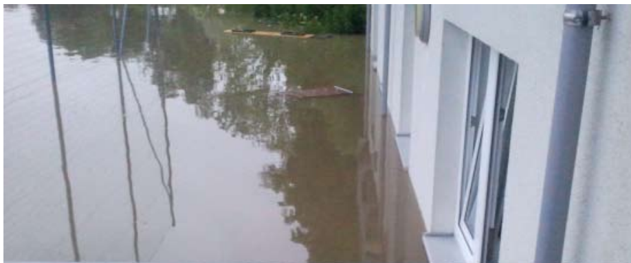
Die Wassermassen sind direkt auf Höhe der Fensterbretter.
