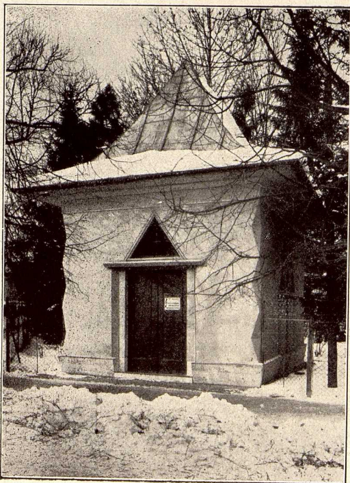
Transformatorhäuschen im Krankenhauspark Erbaut für die Tramway- u. Elektrizitäts-Ges. Linz Entwurf: Stadtbaudirektor Ing. Kurt Kühne
