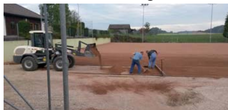
Aufbringung der neuen Tennissandschichten.
