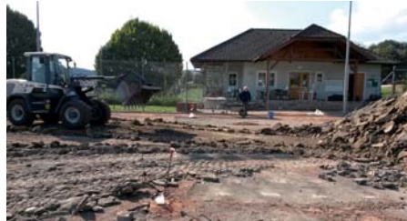
Abtragung des Unterbaus
