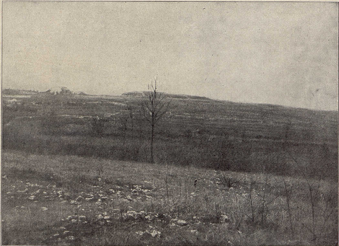
Fort Vaug von Südosten gesehen.
