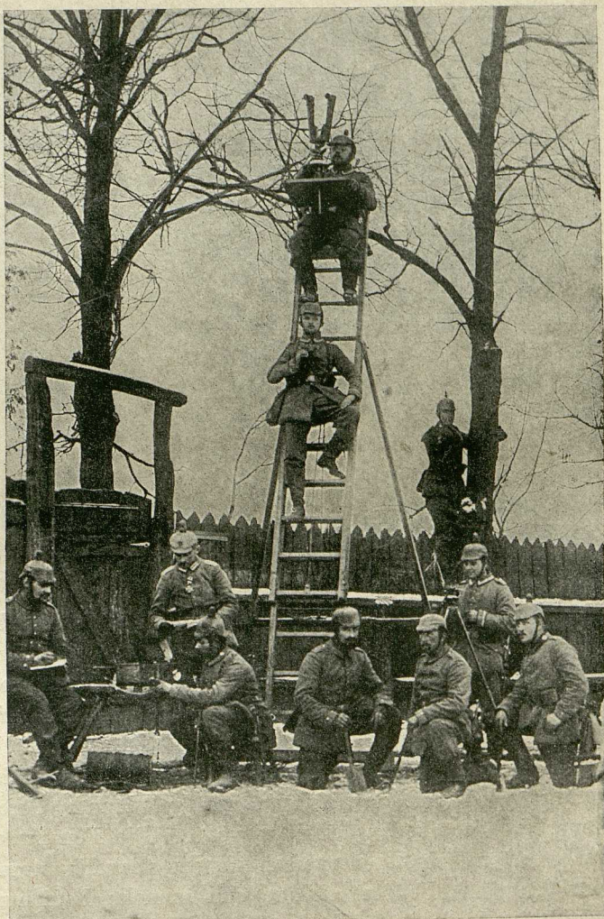
Beobachtungsstelle (aus mitgeführtem Gerät errichtet)
