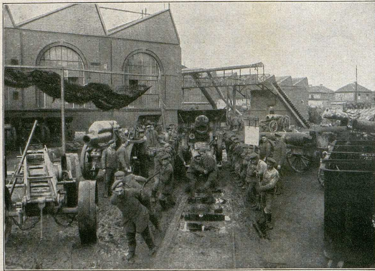
Von der planmäßigen Räumung im Westen: Räumungsarbeiten in einer Artillerie-Werkstatt.
