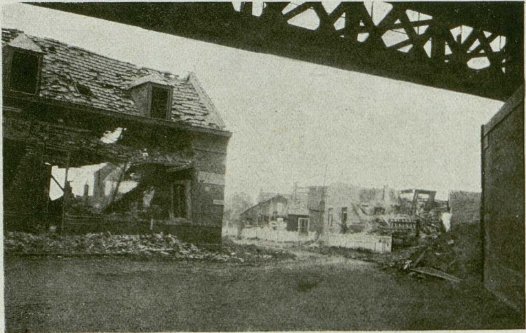
Avion. Unter dem Tunnel, Blick auf die zerstörte Kolonie (Mai 1917) Gefr. Lorenz
