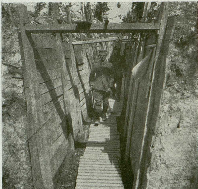
Vimyhöhe. Laufgraben (Mai 1916)
