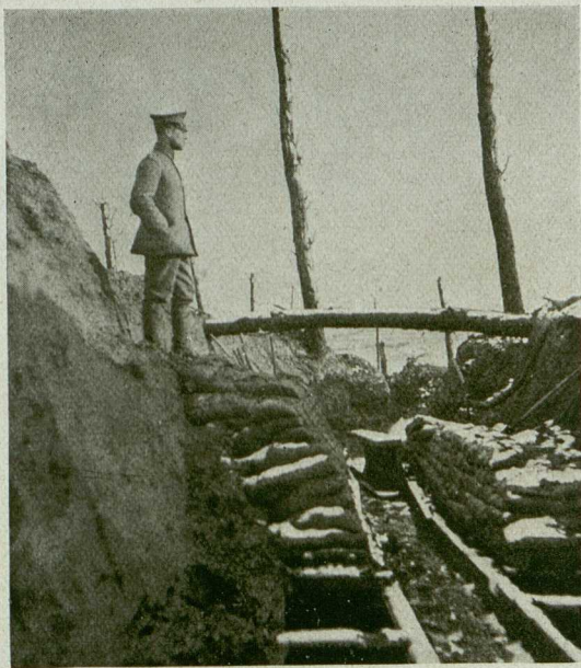
Gießlerhöhe. Kampfgraben mit Entwässerung im Bau (Januar 1916) Ltn. d. R. Meyer
