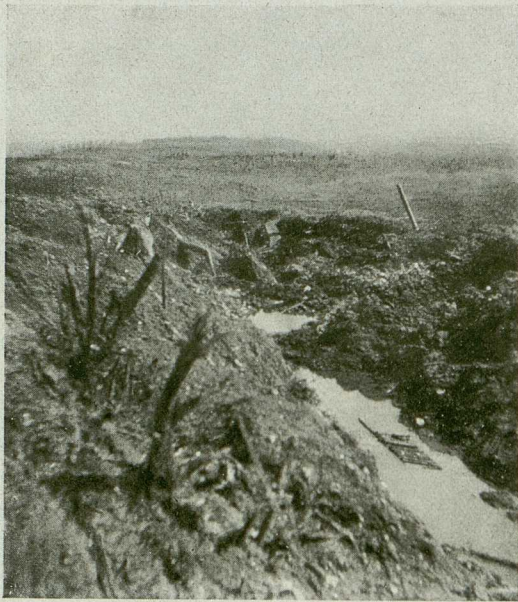
Giëßlerhöhe. Verloffener Graben in der alten Stellung unterhalb der Höhe (februar 1916) Etn. d. R. Meyer
