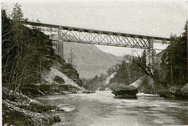
Die obere Teichlbrücke
