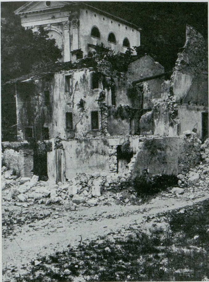
Zerstörte Häuser in Forni (Astico)
