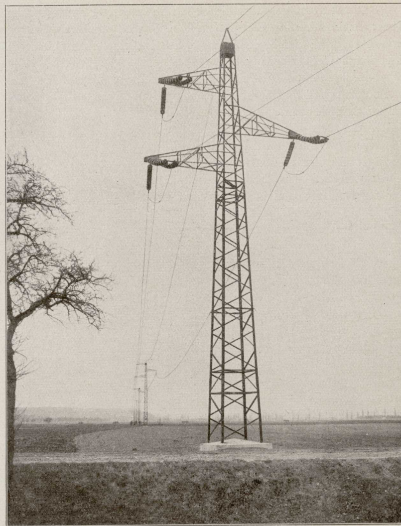
Abbildung 43: Leitung Linz—Steyr, Kreuzungsmast
