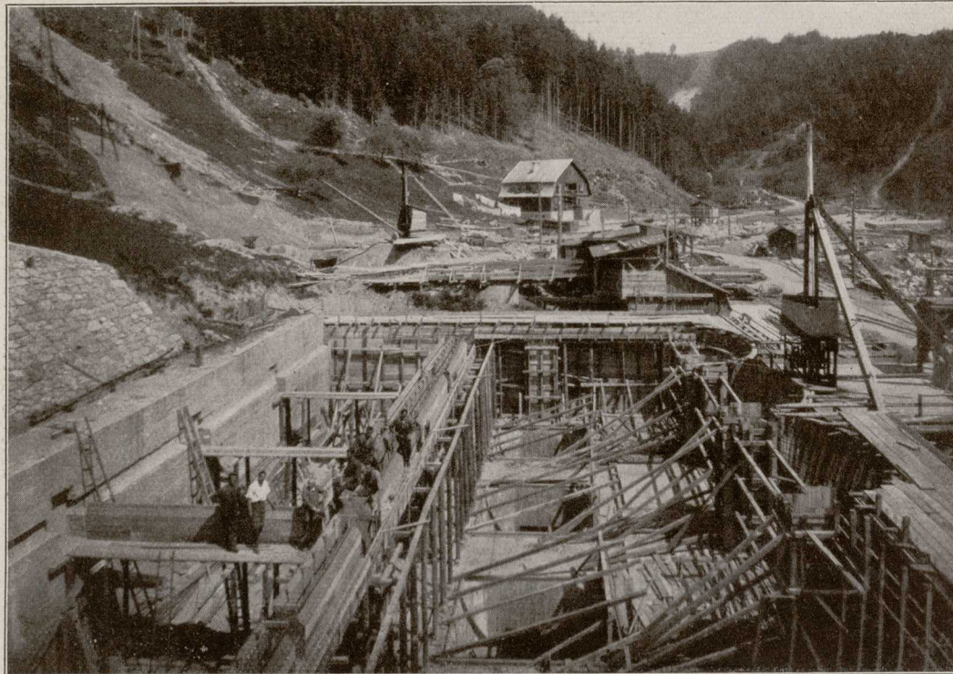
Abbildung 27: Maschinenhaus, Blick auf den Generatorboden, Mai 1923
