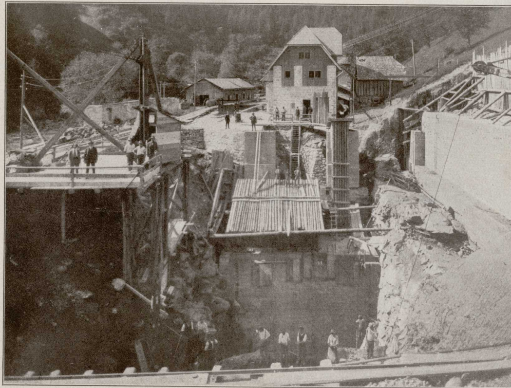
Abbildung 24: Maschinenhausschacht mit Hilfskraftwerk, August 1921
