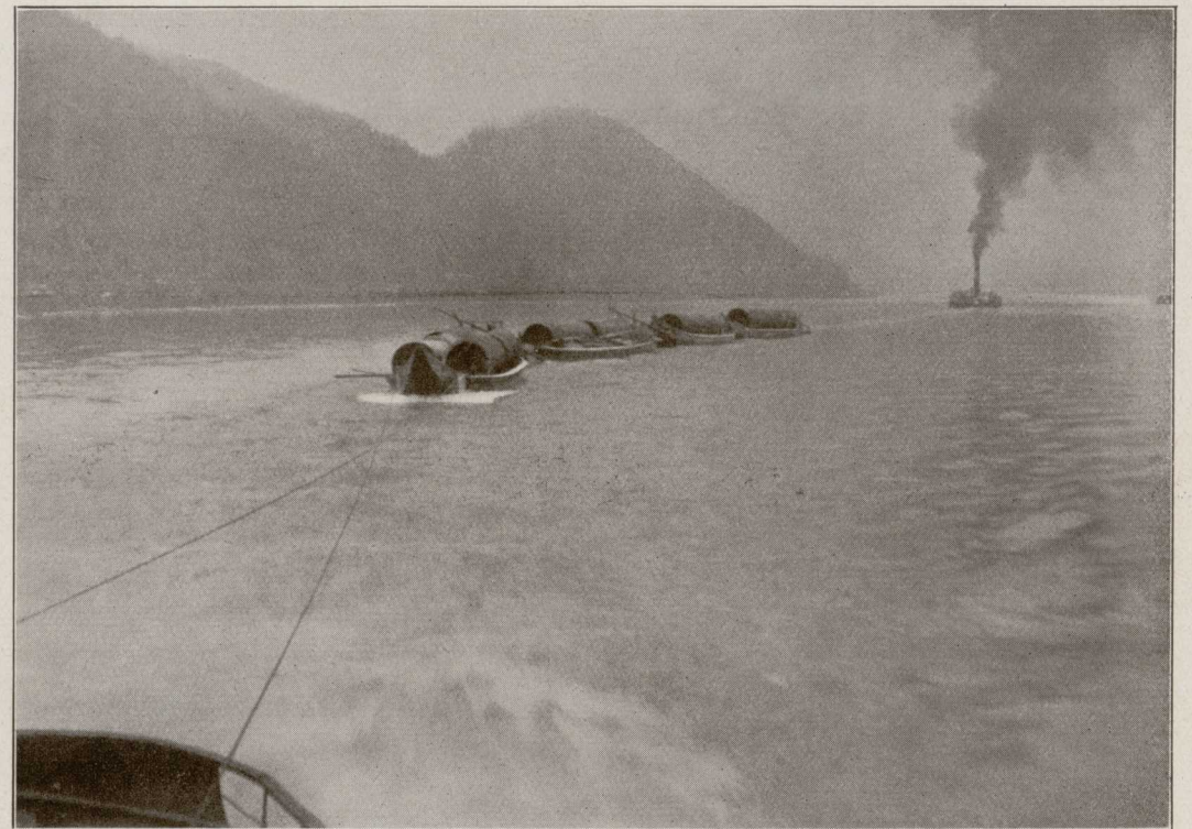
Abbildung 21: Transport der Druckrohre auf der Donau, Jänner 1923
