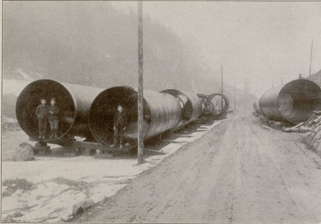
Abbildung 20: Druckrohre auf dem Lagerplatz
