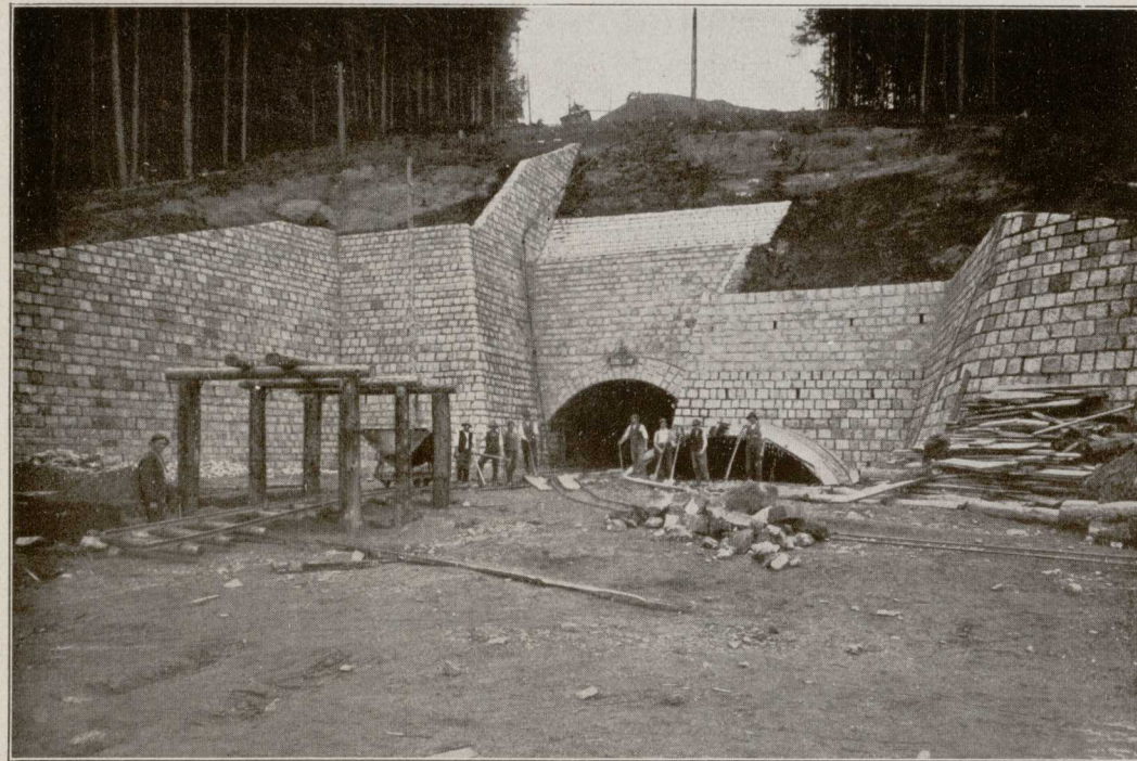
Abbildung 16: Ausmündung des Rohrstollens auf das Planum für das Schieberhaus, Oktober 1923
