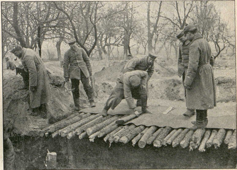
Das sachgemäße Eindecken der fertiggestellten unterirdischen Unterstände.
