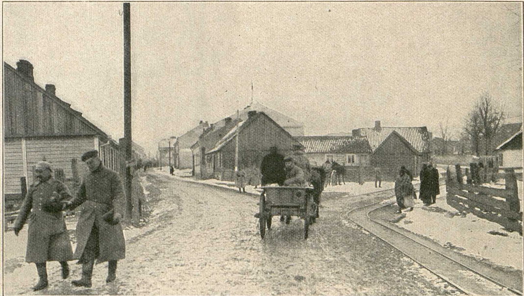
Die Hauptstraße in Kolno.
