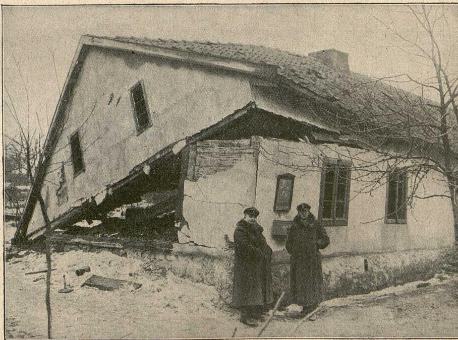
Von einer Granate zerstörtes Haus in Ostpreußen. Die hintere Wand wurde weggerissen, worauf sich das Dach auf die Seite legte.
