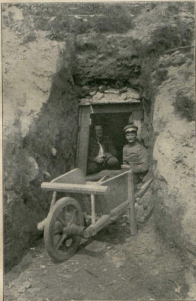
In den Felsen gesprengter Stollen von 15 Meter Länge. 30 Meter hinter der vordersten Linie.
