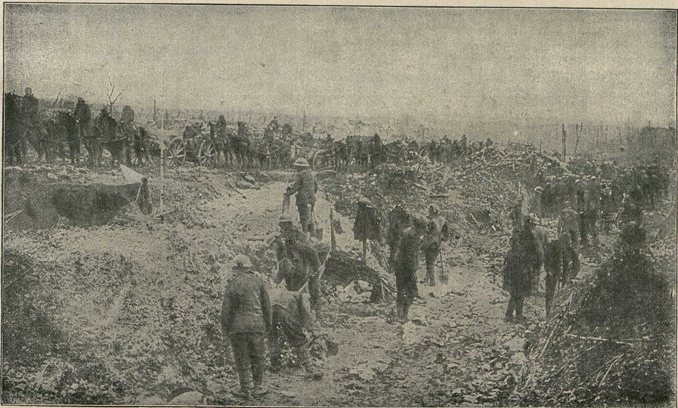
Englische Pioniere im Westen beim Bau einer neuen Straße nach der Front. Nach einer englischen Darstellung.
