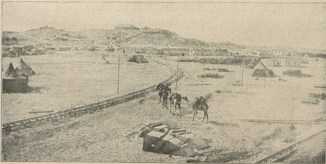
Eine von den Türken während des Krieges erbaute Wüstenbahn mit Stappenstation an der Front von Gaza. Auf dem Hügel im Hintergrund ein deutsch-türkisches Lazarett.
