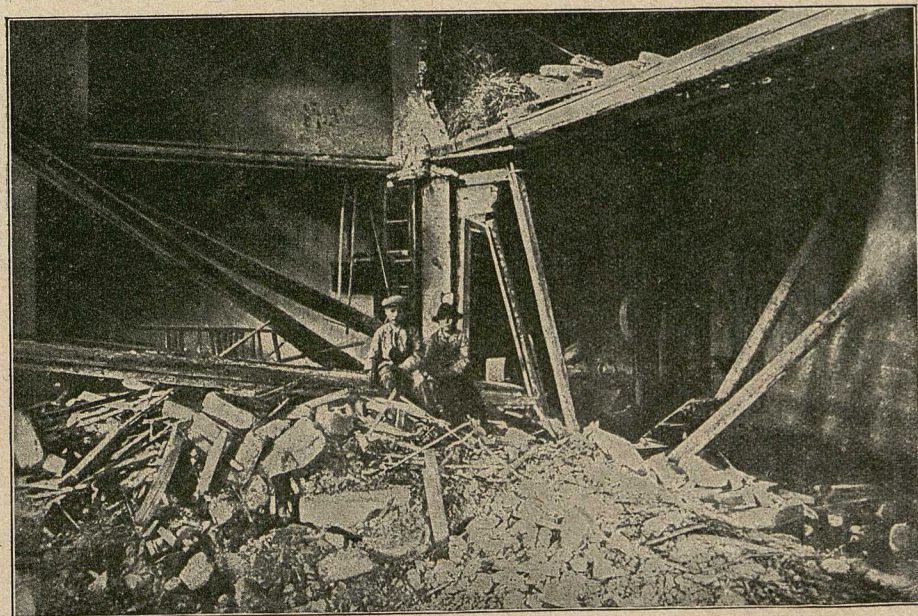
Ein zerstörtes Haus mit zwei aus den Trümmern geborgenen Kindern. Zum feindlichen Fliiegerangriff auf die offene Stadt Trier.
