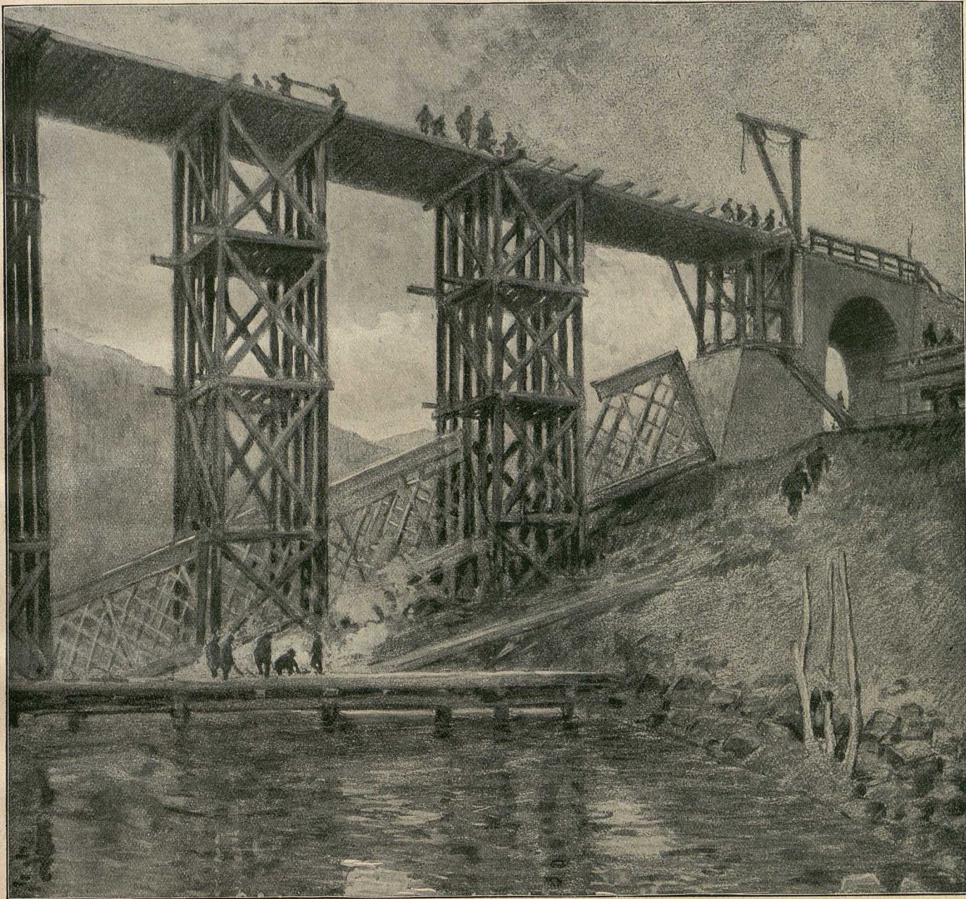
Die Kriegsbrücke bei Cainei in Rumänien, von einer württembergischen Ersatz-Bahnkompanie in acht Tagen erbaut. Nach einer Originalzeichnung des auf dem rumänischen Kriegsschauplatz zugelassenen Kriegsmalers A. Reich-München.
