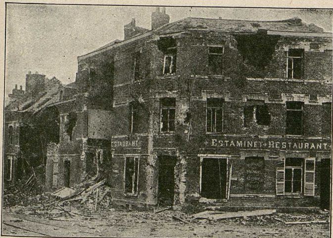
Häuferruinen der Rue de Paris.
