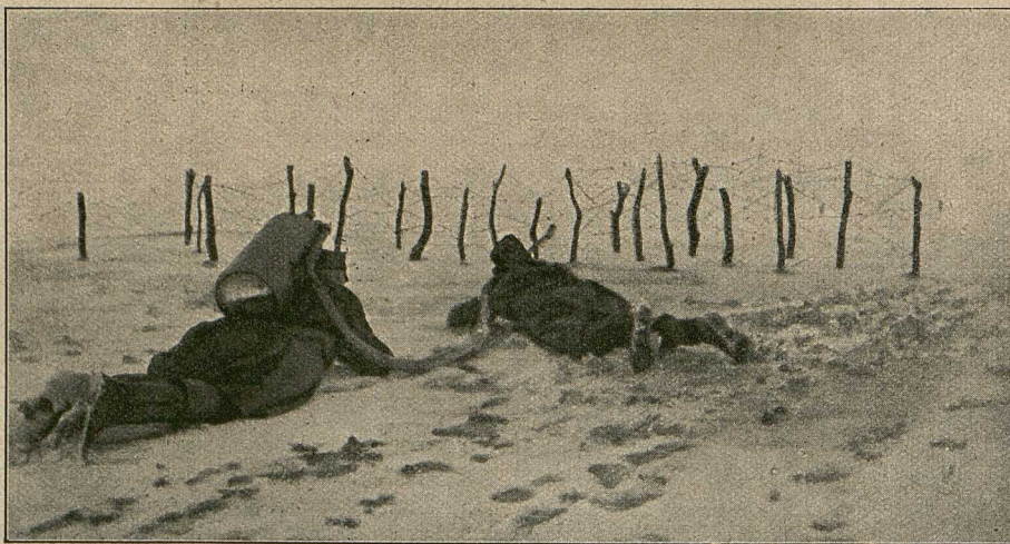
Österreichisch-ungarische Flammwerfer-Schleichpatrouille vernichtet feindliche Drahthindernisse im Osten.
