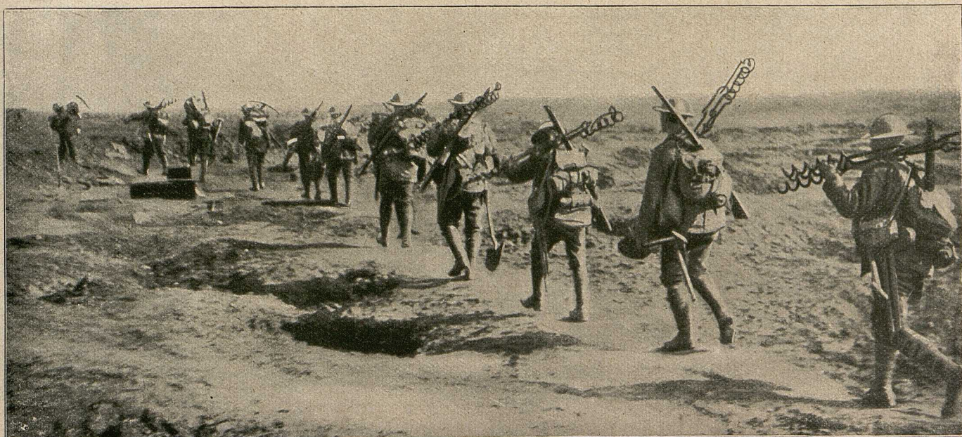
Englische Soldaten begeben sich an die Front, um neue Drahtverhaue anzulegen, zu deren Befestigung sie an Stelle der Holzpföcke Eisenstäbe benötigen, die an einem Ende schraubenförmig gebogen sind und sich deshalb leicht in den Boden bohren lassen.
