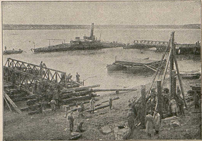
Phot. M. F. u. F. Die Brücke während des Baues.
