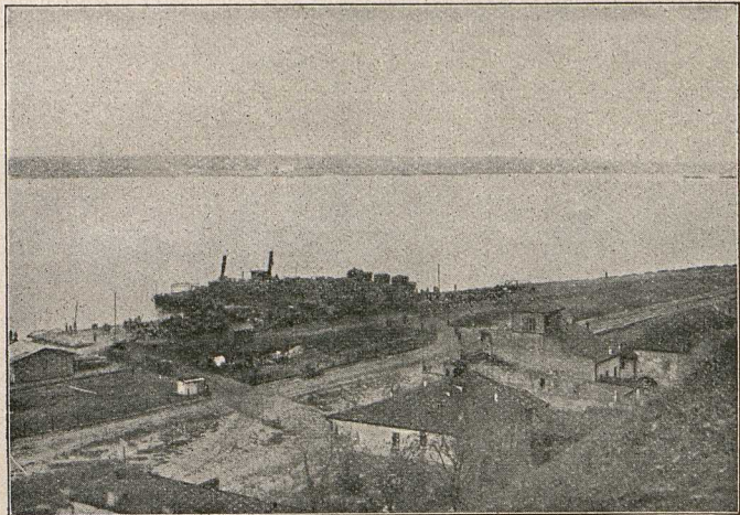
Phot. M. F. u. F. An der Aufbaustelle der Brücke.
