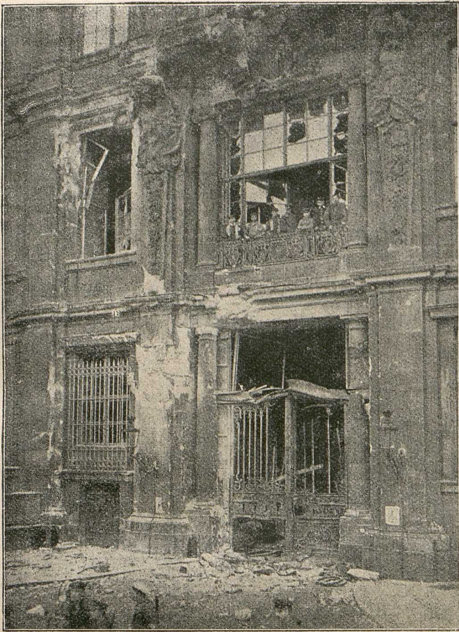
Der Haupteingang des königlichen Schlosses in Berlin nach der Beschädigung.
