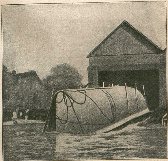
Das dänische Betonboot „Beton I“ verläßt Kieloben die Bauhalle.
