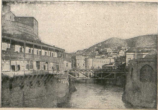
Die engste Stelle der Kura mit den auf den Felsen errichteten Gebäuden.
