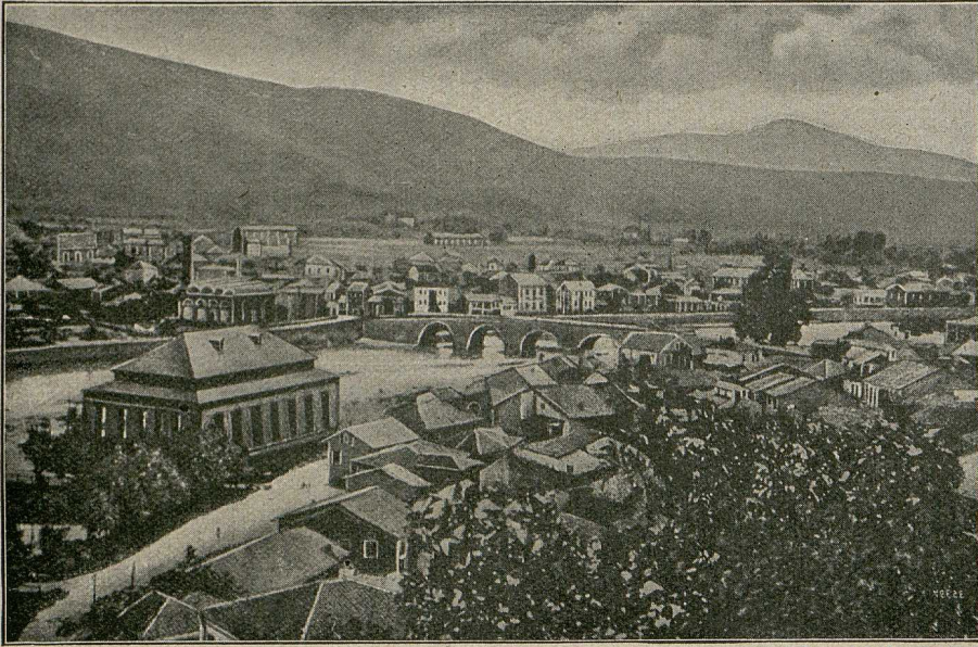
Utsicht mit der Wardarbrücke.
