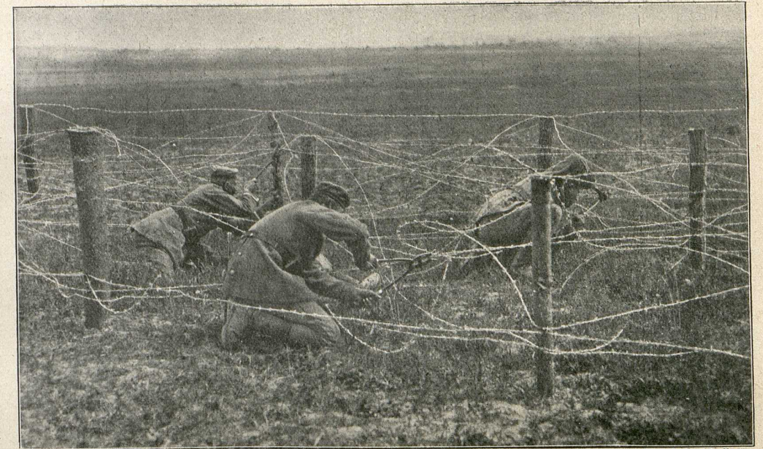
Pioniere beim Zerschneiden der russischen Drahtverhaue.
