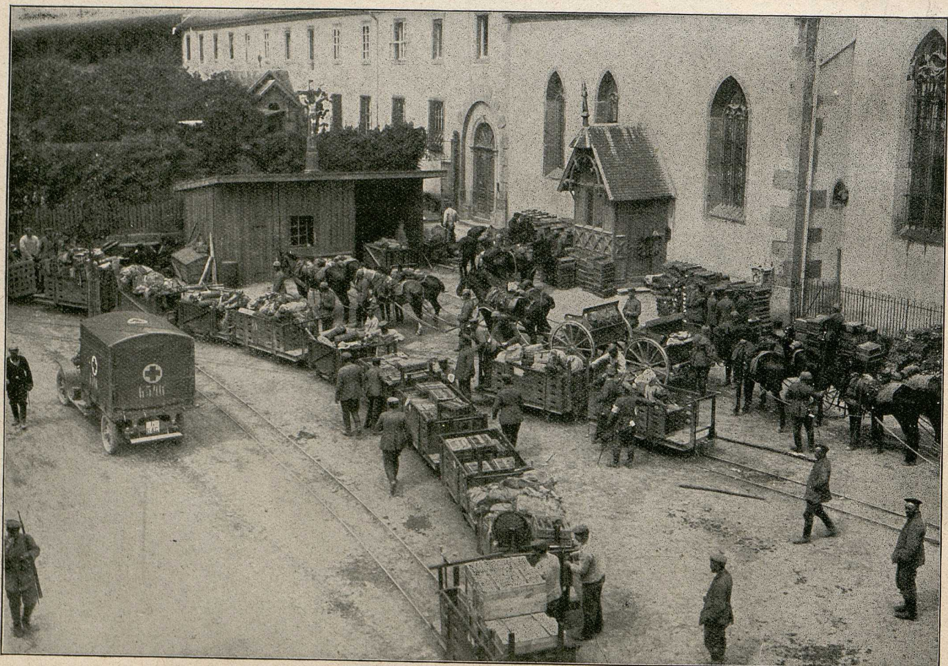
Eine von Armierungsgruppen hergestellte Feldbahn, mit der die Munition bis in die vordersten Stellungen geführt wird. Offphot. Eberth, Cassel.
