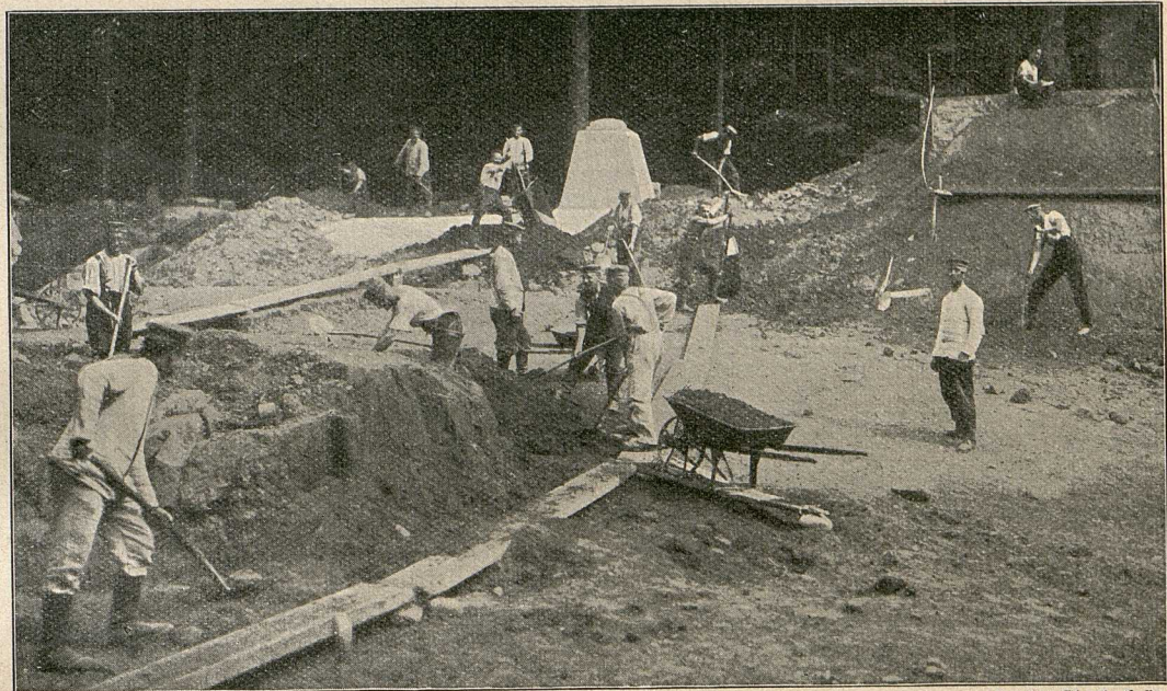
Berliner Landsturm beim Bau einer Wasserleitung. Im Hintergrund der fertige Hochbehälter. Fotophot. Eberth, Cassel.
