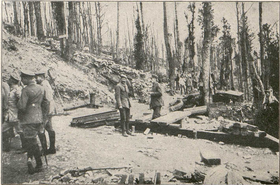
Bau von bombensicheren Unterständen und Verbindungsgräben dicht hinter dem östlichen Kruppenrand.
