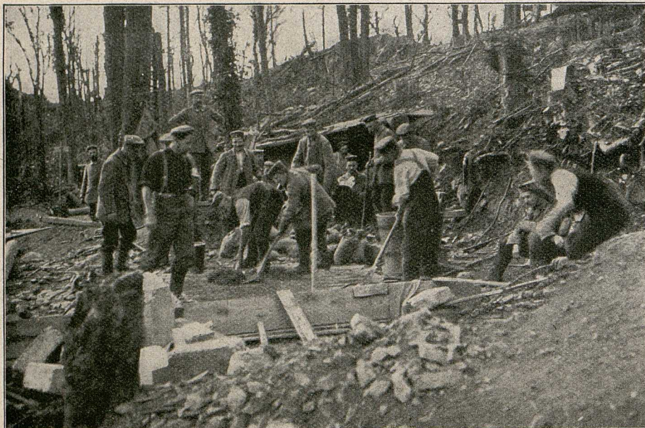
Säcke werden mit nassem Zement gefüllt.
