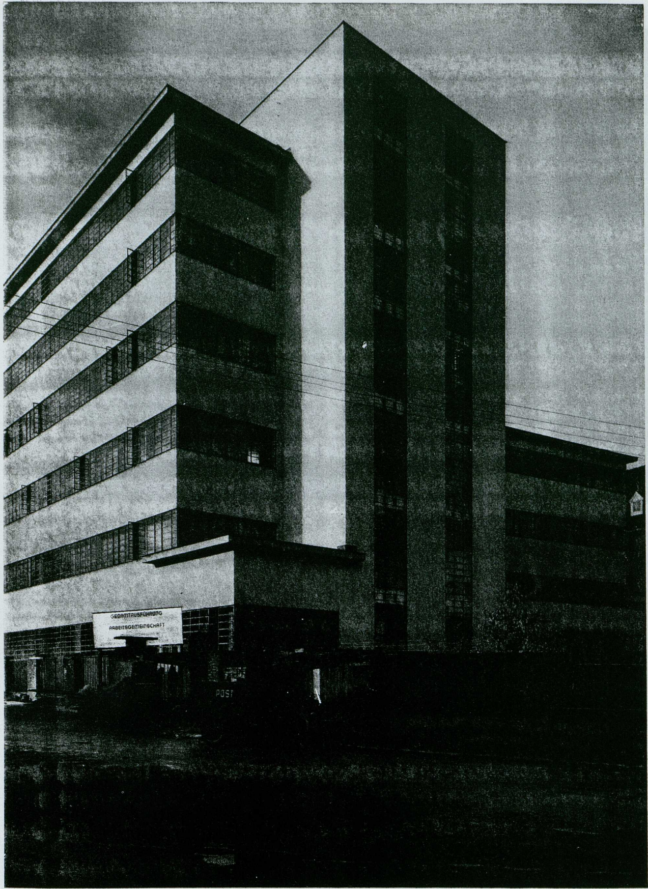
Fabrikationsgebäude I mit Stiegenhaus
