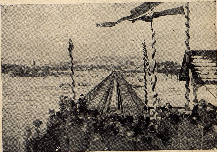
Eisenbahnbrücke zwischen Braunau und Simbach (Bayern)
